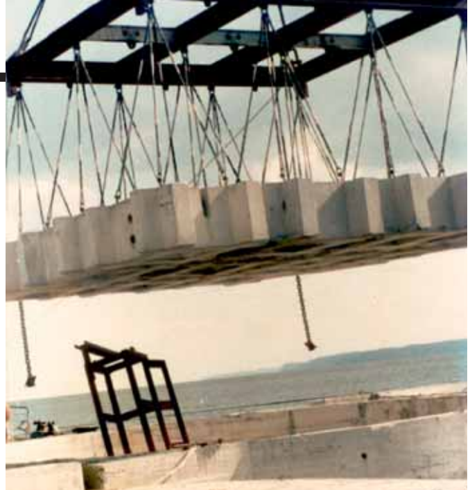
Abb. 6 Aufnahme der Koppelplatte zur Verlegung
