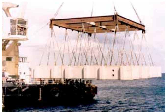
Abb. 7 Verlegung der Koppelplatte im Luvbereich der Nordmole des Fährhafens Mukran
